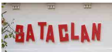
La nouvelle façade du Bataclan.
